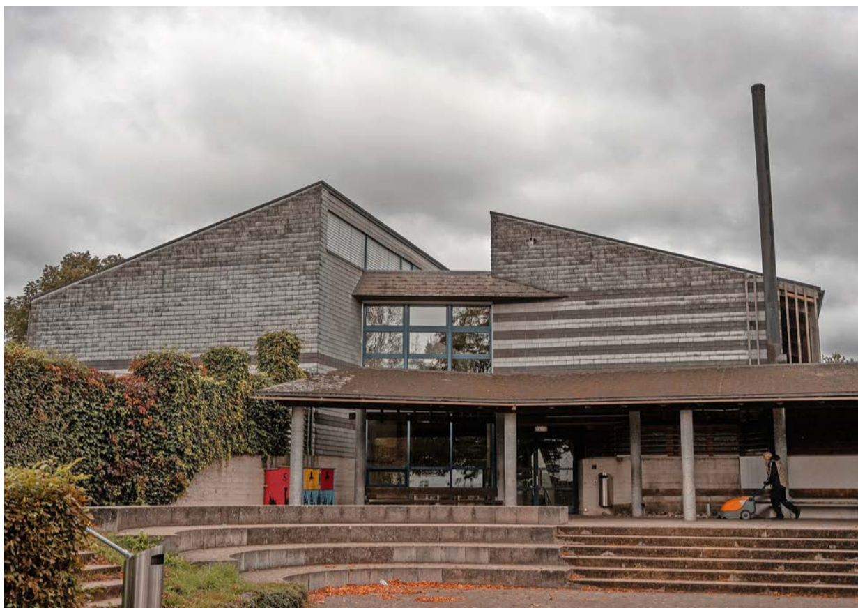
Ramsen macht vorwärts mit den Schulhausbauten.
